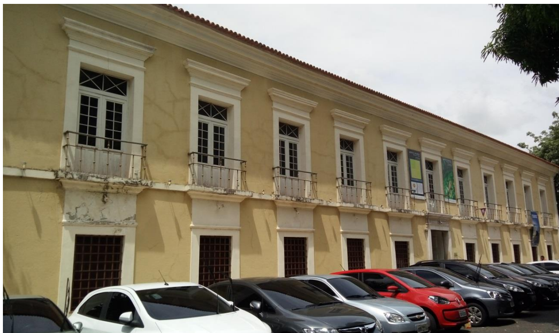
Figura 3: Fachada do Museu Casa das Onze Janelas.
