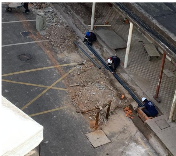
Figura 12 - Instalação dos Eletrodutos
