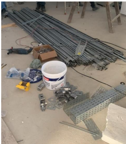
Figura 20 - Eletrodutos, Eletrocalhas e Conduletes Metálicos
