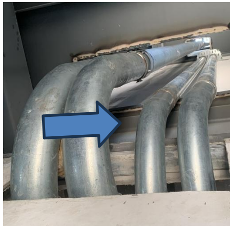
Figura 30 - Subida do Segundo ao Terceiro Pavimento da Caldeira
