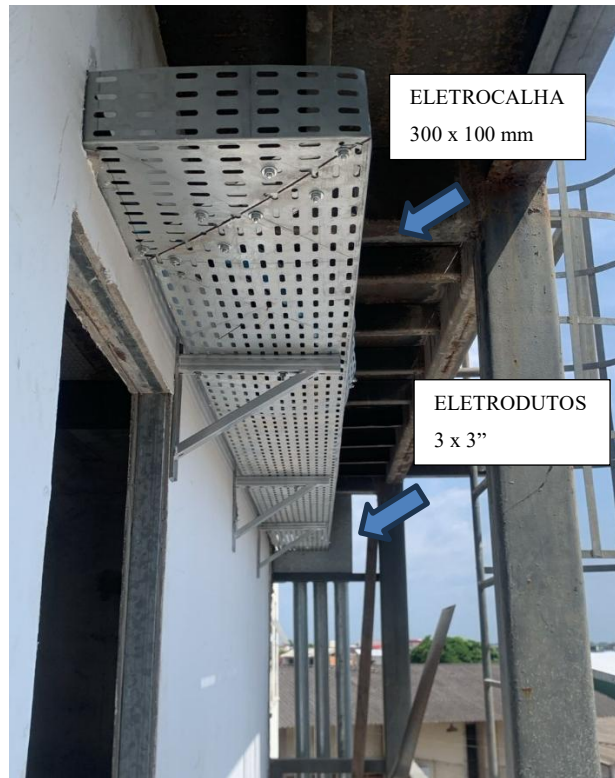
Figura 14 - Conexão Entre eletroduto e Eletrocalha
