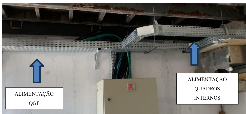
Figura 15 - Conexões do QGF
