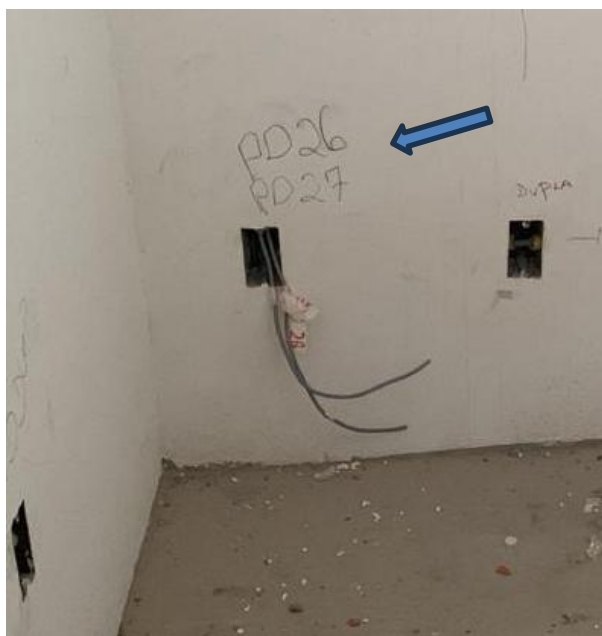
Figura 25 - Marcações Na Parede
