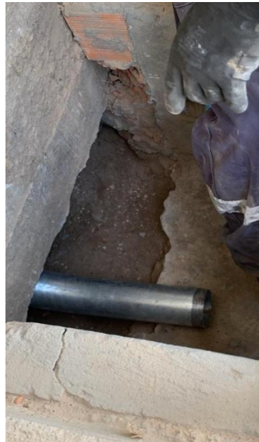
Figura 11 - Instalação de Eletrodutos Sob o Piso
