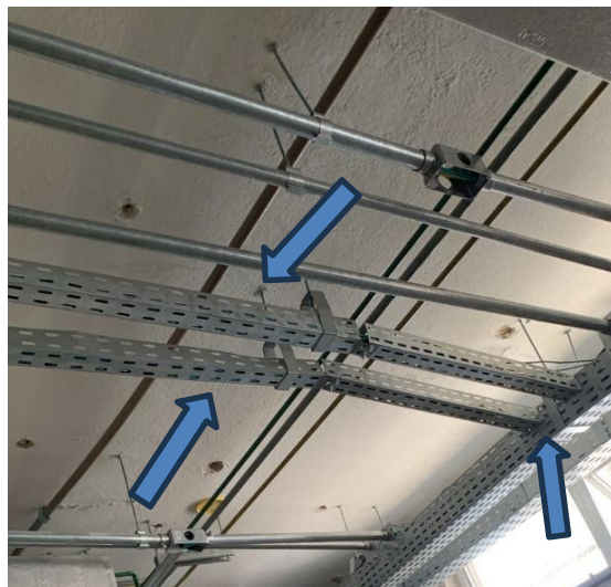
Figura 47 - Conexão das Eletrocalhas 50 x 50 mm na Principal
