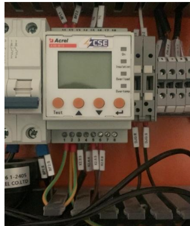
Figura 42 - DSI Instalado
