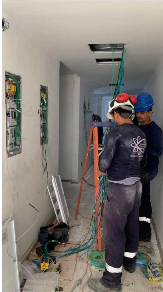
Figura 45 - Passagem dos cabos dos Quadros IT
