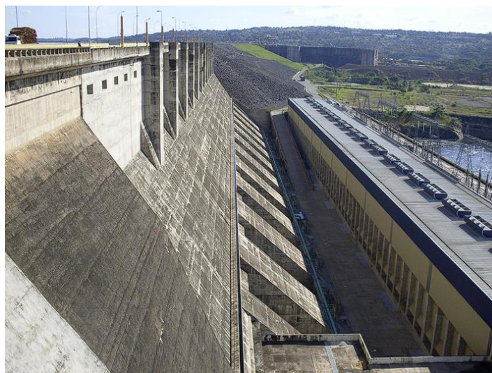
Figura 3 – Barragem de concreto por gravidade aliviada.
