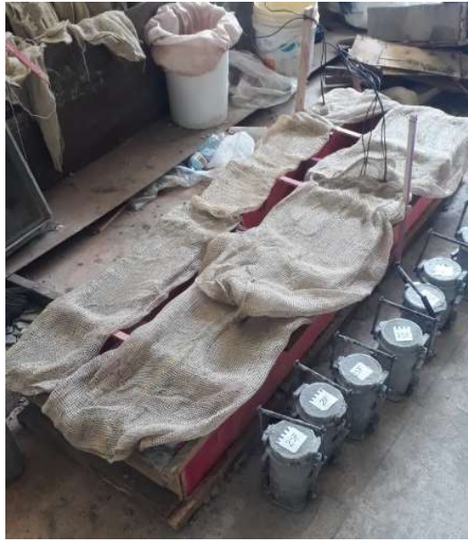
Figura 3.16: Vigas em processo de cura após a concretagem, rodeadas por seus respectivos corpos de prova
