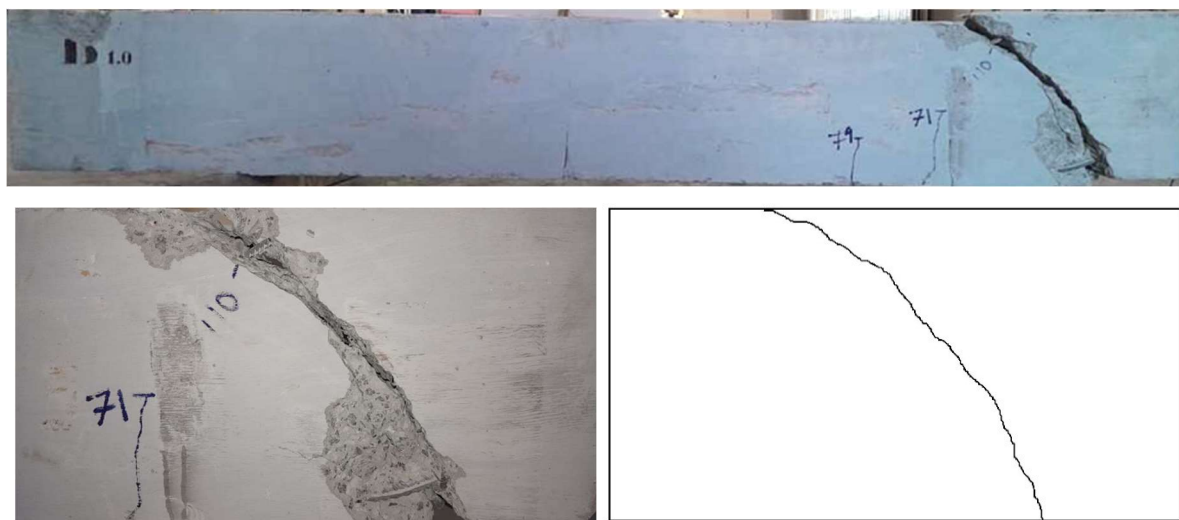
Figura 4.5: Padrão de fissuração da viga B 1.0
