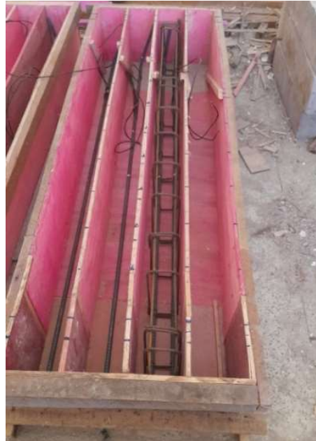
Figura 3.15: Armadura posicionada na forma de uma viga antes da concretagem
