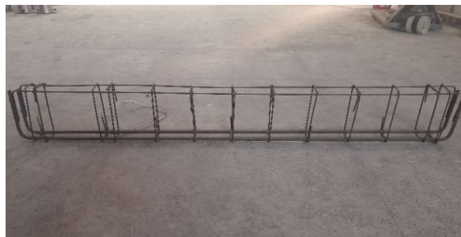
Figura 3.14: Armadura da viga B 2.0 completamente montada.
