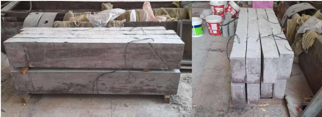
Figura 3.17: Vigas após execução da desforma
