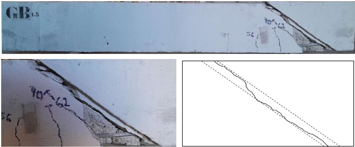
Figura 4.8: Padrão de fissuração da viga GB 1.5
