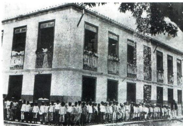
FIGURA 1 - Foto da Prédio da Escola Basílio de Carvalho
