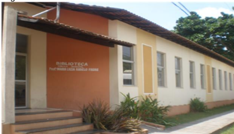
Figura 2 – Prédio da Biblioteca em 2008.
