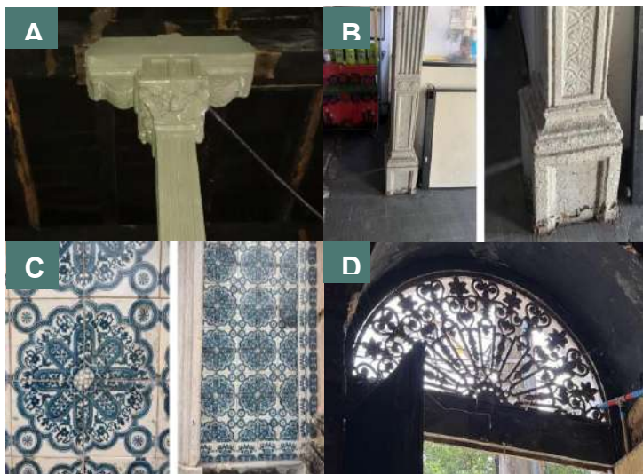
Figura 27 - Detalhes estéticos da edificação. A) e B) Detalhes do pilar de ferro; C) Azulejos constituintes da fachada; D) Detalhe em ferro da bandeira da porta.
