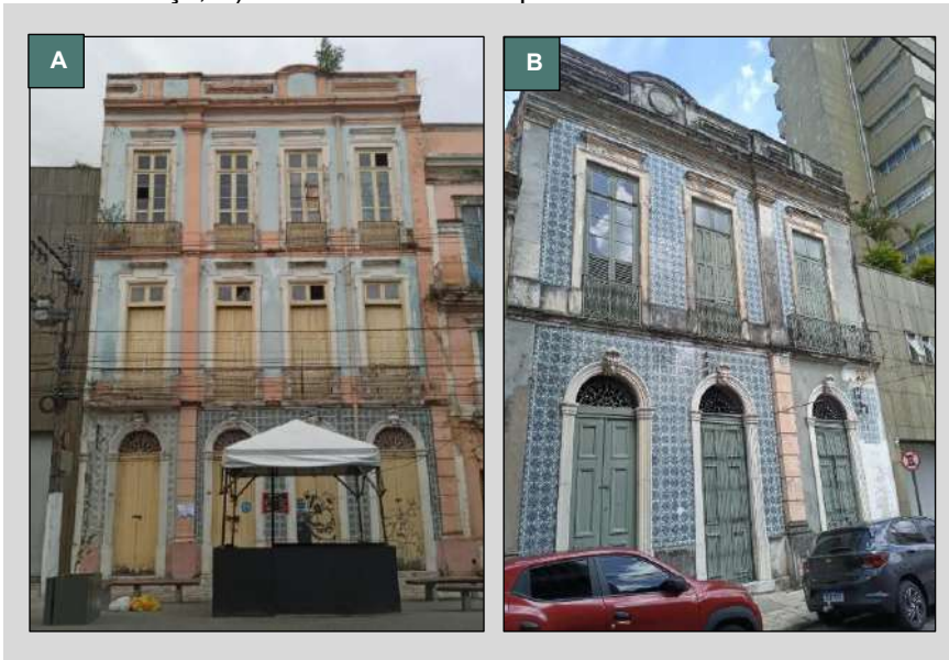
Figura 22 - As duas fachadas da edificação. A) Fachada da rua Boulevard Castillo França; B) Fachada da rua Gaspar Viana.
