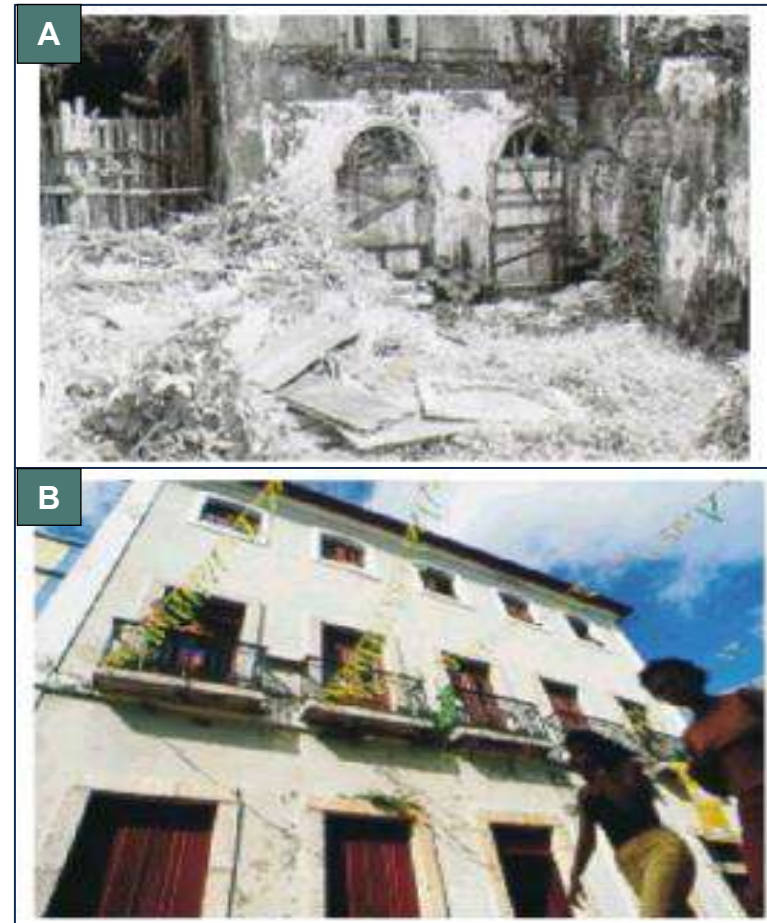
Figura 9- Imóvel de intervenção para uso habitacional em São Luís. A) Imagem da edificação degradada e abandonada antes da revitalização; B) Imagem da edificação pós-revitalizada.
