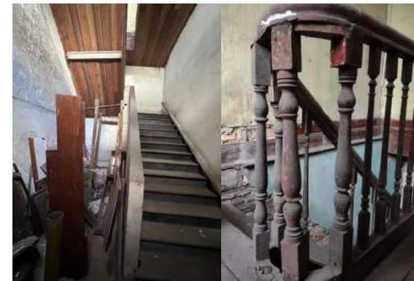
Figura 42 - Detalhes da escada que dá acesso ao 2º pavimento. O acesso a escada se dá pela rua Gaspar Viana.
