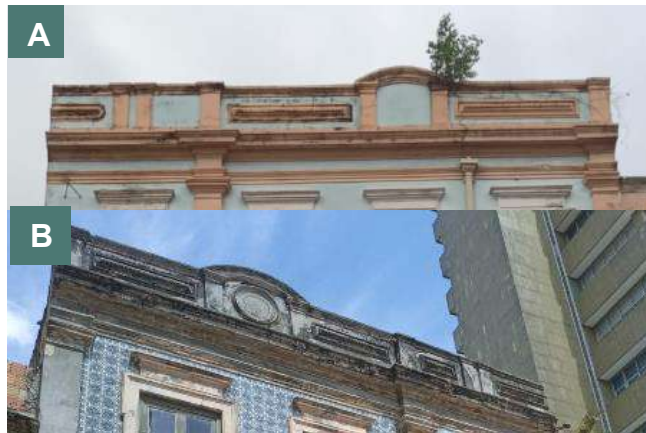
Figura 35 - Detalhe das platibandas e coroamento em arco. A) Fachada Boulevard Castillo França; B) Fachada Gaspar Viana.
