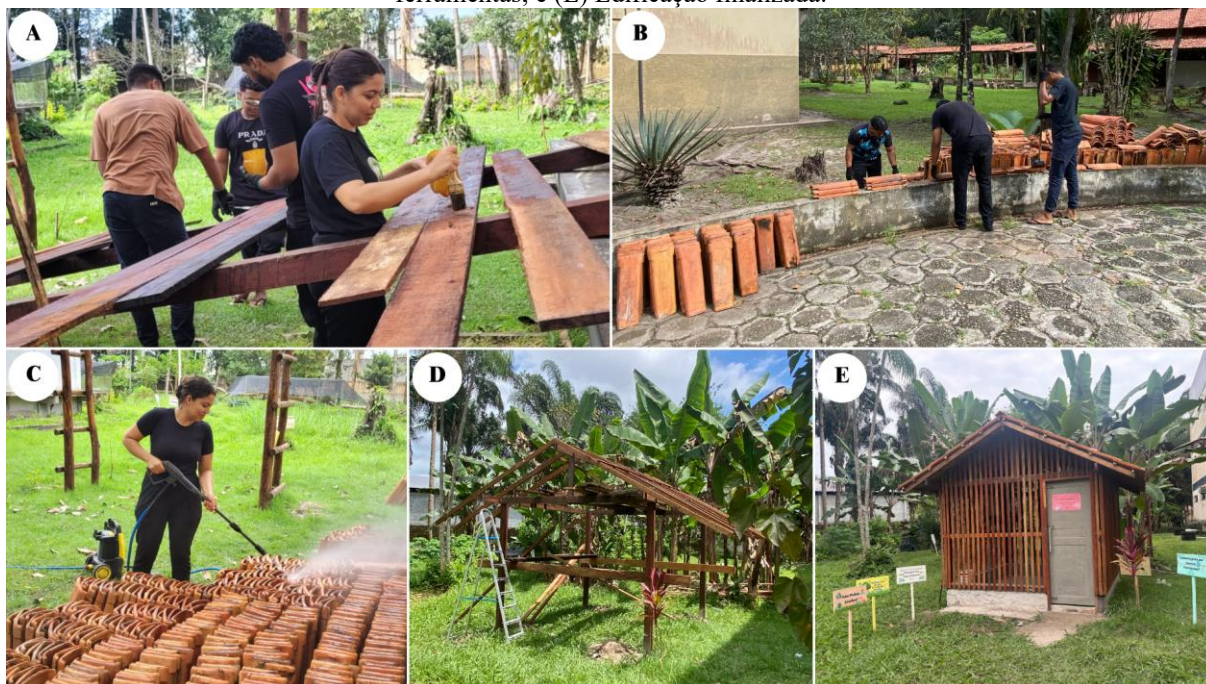
Figura 7 – Etapas de edificação da casa de ferramentas: (A) Tratamento preventivo das madeiras; (B) Triagem e seleção de telhas; (C) limpeza manual de telhas cerâmicas reaproveitadas; (D) Execução estrutural da casa de ferramentas; e (E) Edificação finalizada.
