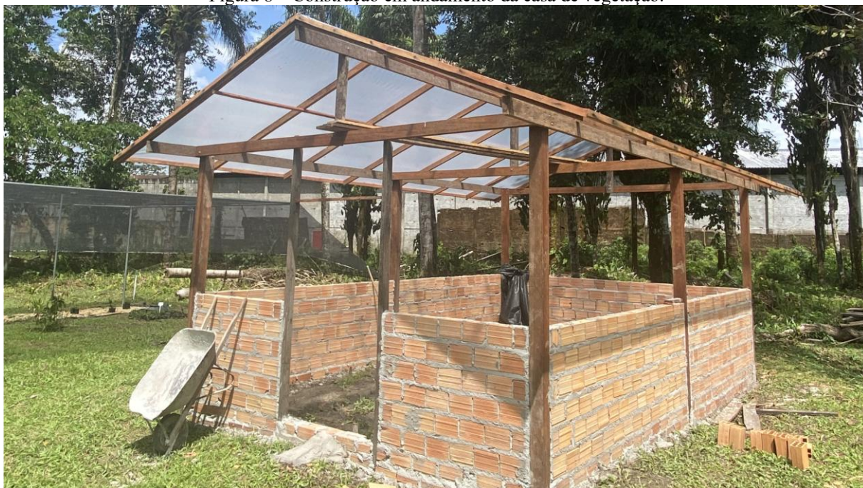
Figura 8 – Construção em andamento da casa de vegetação.
