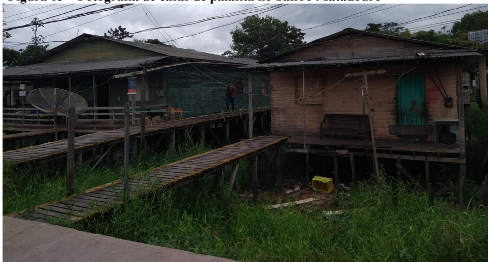
Figura 05 – Fotografia de casas de palafita no bairro Matadouro
