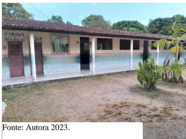
Figura 5- Área e corredor do bloco 02.
