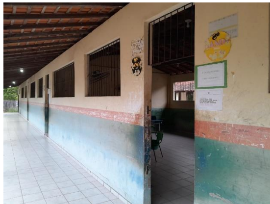
Figura 2- Corredor do Bloco 01
