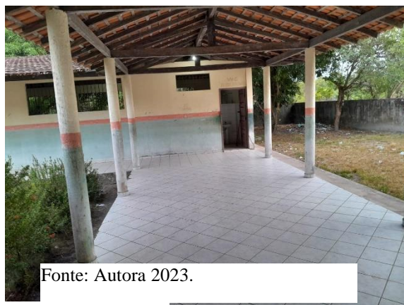
Figura 3- Vista do corredor que dá acesso aos banheiros.
