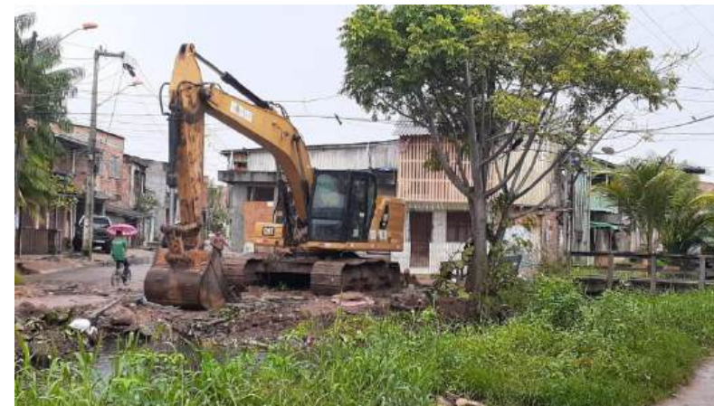
Figura 26: Início da obra, com a demolição do espaço comunitário.
