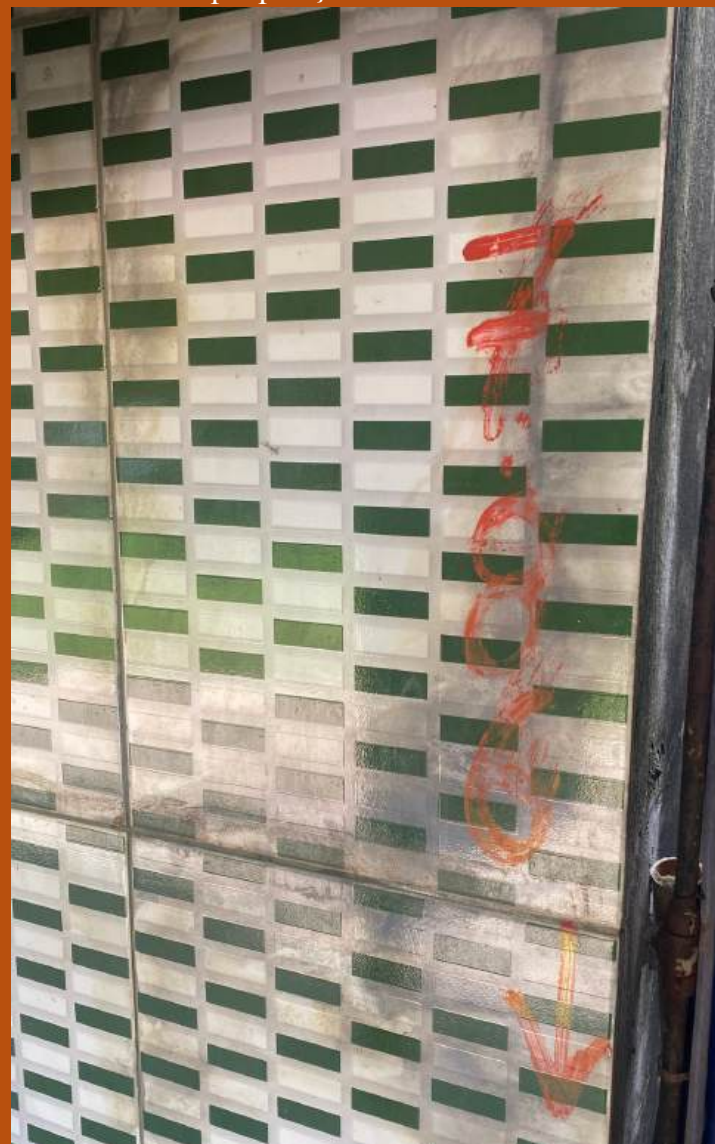
Figura: Marcação da linha de corte no lote referente a faixa de desapropriação da obra.
