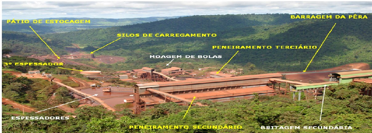
Foto9: Visão Mirante Industrial da Mina de Ferro Carajás Fonte: Autor, Outubro 2007
