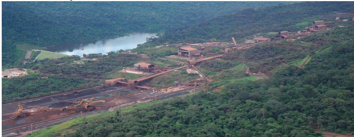
Foto10: Visão Aérea da Planta Industrial da Mina de Ferro Carajás Fonte: Autor, Março 2008
