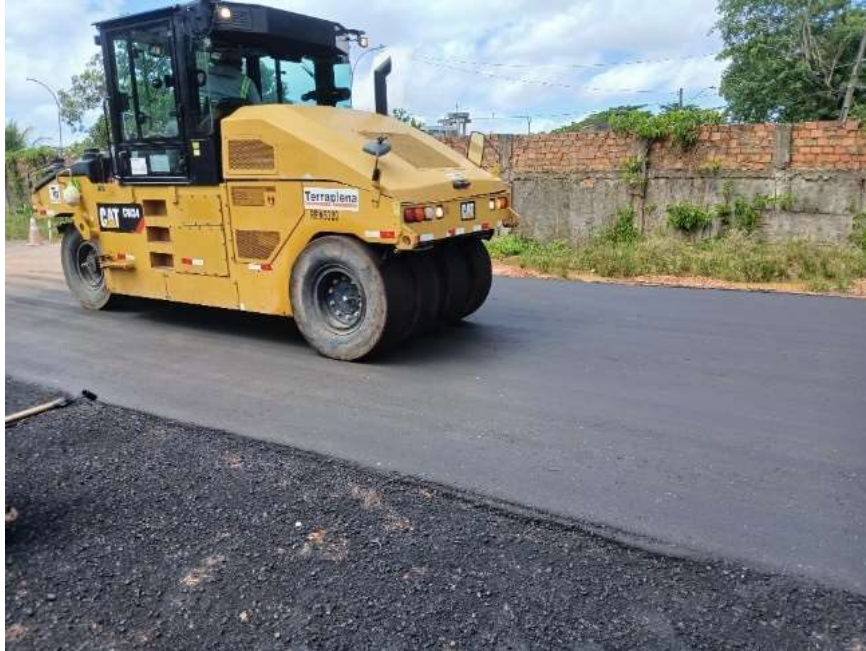
Figura 57 - Compactação por rolo pneumático
