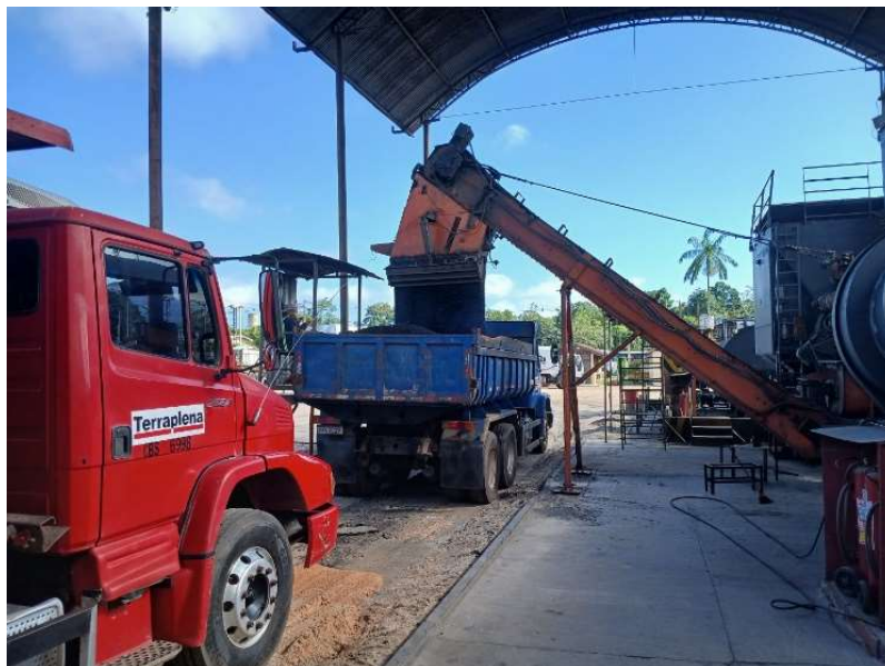
Figura 37 - Despejamento do material da misturadora no caminhão
