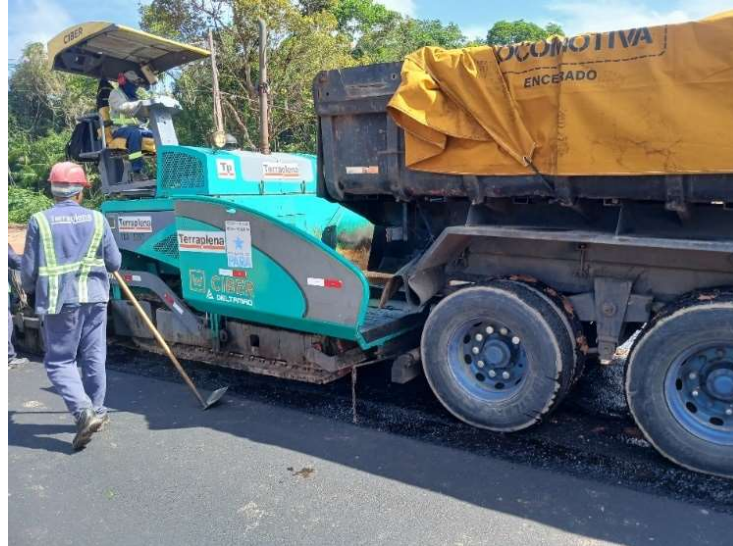
Figura 53 - Descarregamento da mistura asfáltica
