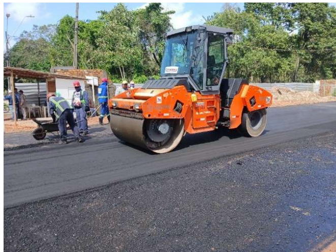
Figura 56 - Compactação do trecho por rolo liso tandem metálico
