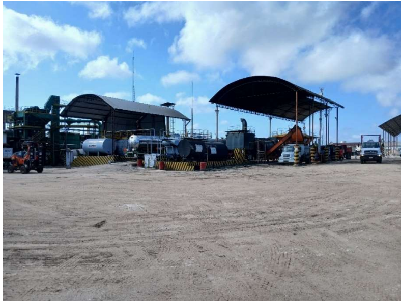
Figura 26 - Usina de asfalto
