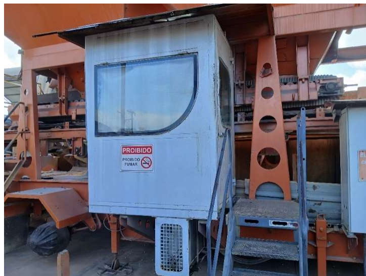
Figura 29 - Cabine de controle da usina
