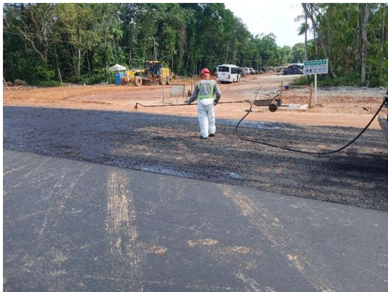
Figura 52 - Processo de pintura da superfície
