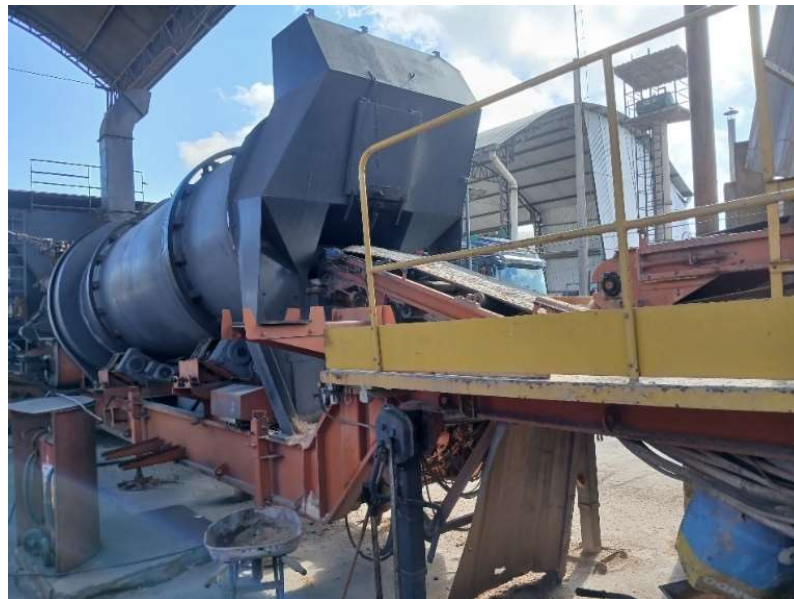
Figura 31 - Lançamento dos agregados para a secagem
