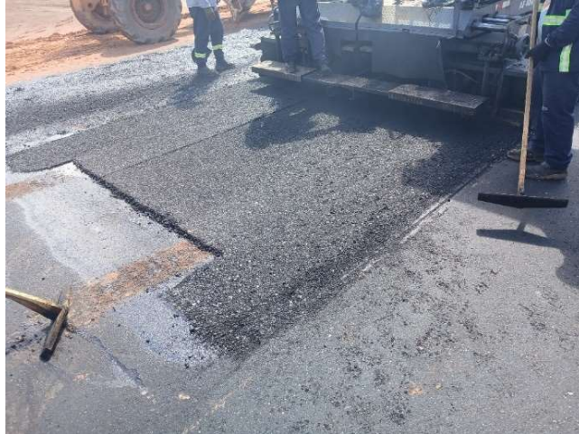
Figura 55 - Lançamento da mistura asfáltica com acabamento preliminar
