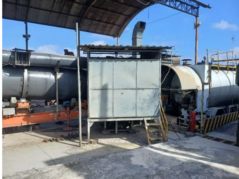
Figura 32 - Silo de armazenamento do material de enchimento
