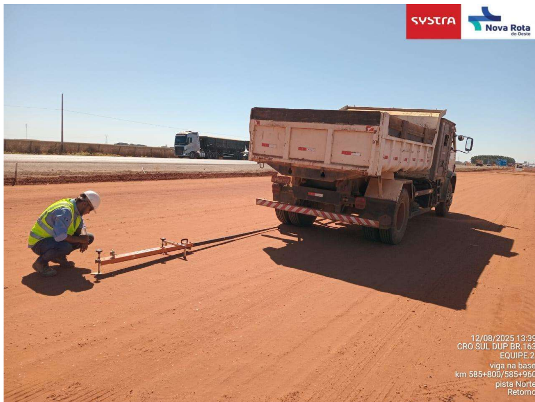
Figura 18 - Ensaio de viga Benkelman realizado em trecho de obra viária
