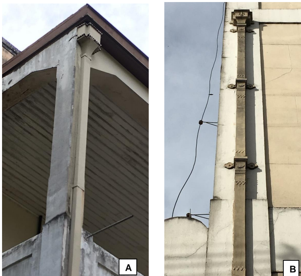
Figura 11A. Calha Similar; Figura 11B. Calha MacFarlane's. Fotografia do autor.
