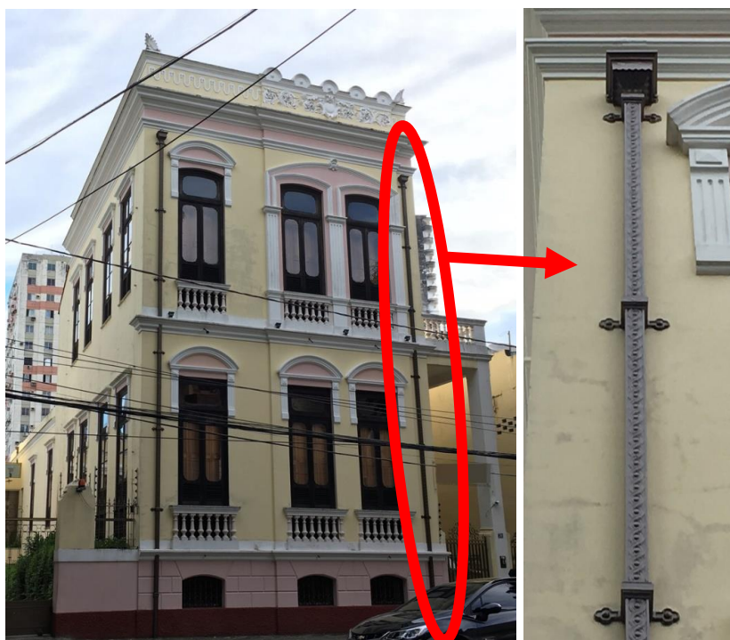
Figura 1. Detalhe de edificação no bairro de Nazaré com diversos elementos ornamentais em ferro: calha em ferro. Fotografia do autor.
