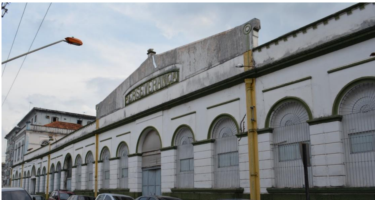
Figura 5. Fachada lateral do prédio da ESAMAZ, com calhas de ferro MacFarlane's no Reduto. Fotografia do autor.
