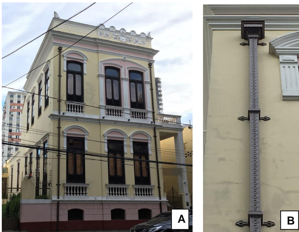
Figura 1A. Construção Histórica no Bairro de Nazaré; 1B. Detalhe da calha de ferro ornamentada.
