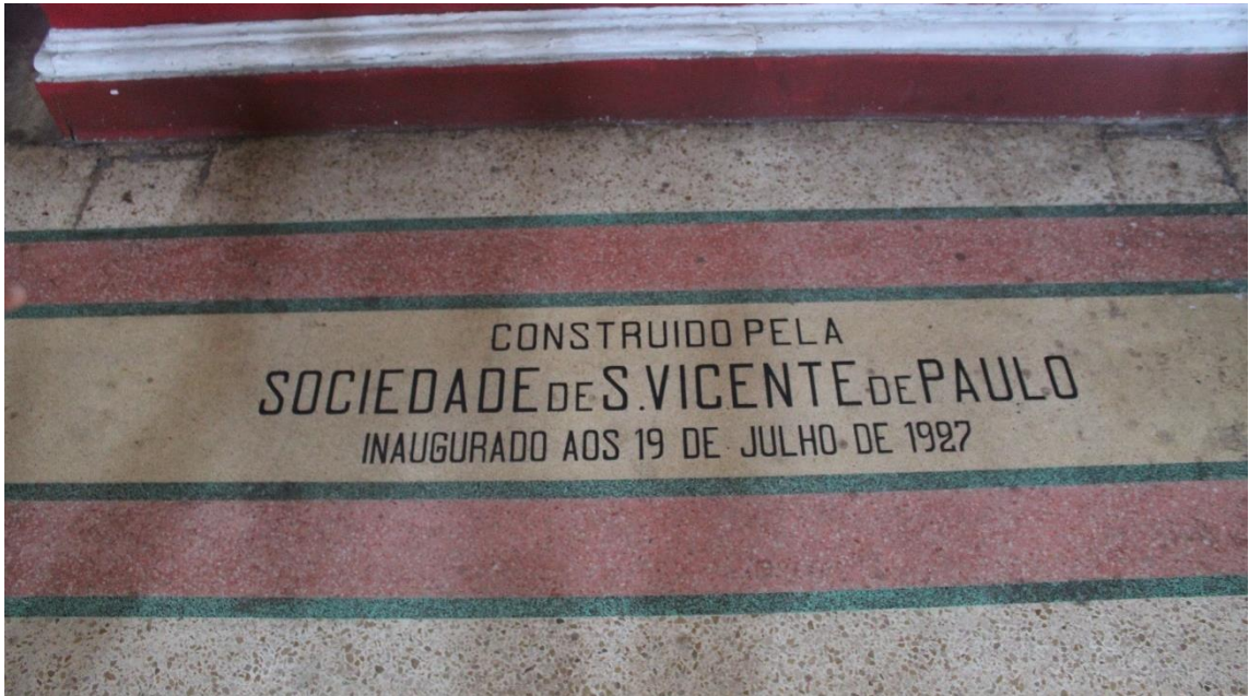
Figura 64: Revestimento do piso em ladrilho hidráulico de uma das capelas parietais dedicada a São Vicente de Paulo, datada de 1927.
