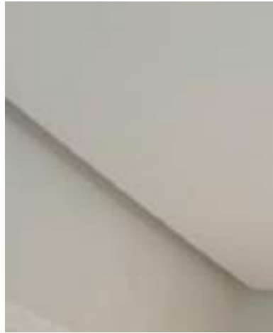
Figura 48: Forro em gesso branco fosco com dilatação (imagem do Google).
