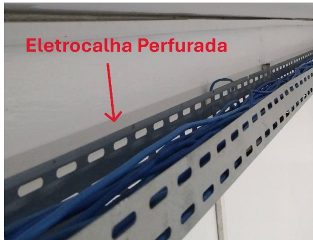
Figura 18 - Eletrocalhas perfuradas
