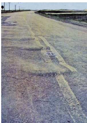
Figura A.7 - Ondulação ou Corrugação.
