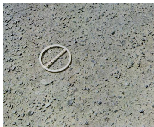
Figura A.9 – Desgaste.
