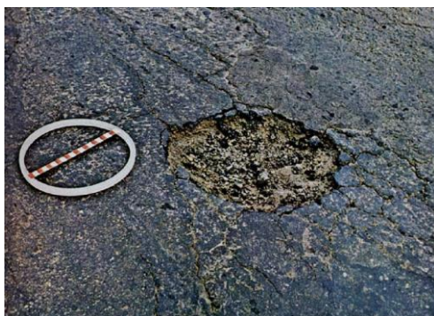
Figura A.10 - Panela ou buraco.
