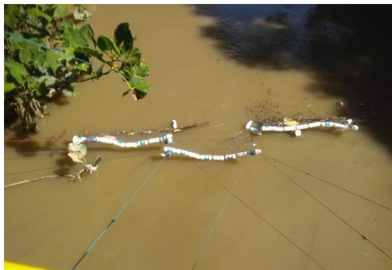
Figura 8 Instalação dos 3 módulos de ecobarreira tipo 1 no rio Tucunduba.
