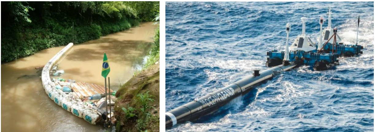
Figura 3 - Modelos de ecobarreiras já desenvolvidos e em operação no Brasil e exterior. A) Ecobarreira desenvolvida por Diego Saldanha, modelo de baixo custo, B) Ecobarreira desenvolvida por Bob Slat, para reter os resíduos do oceano pacífico, modelo de alto custo.
