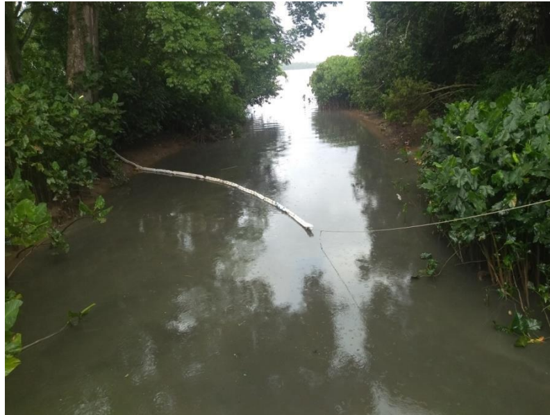
Figura 9 Instalação da ecobarreira tipo 2 no rio Tucunduba, estendida desde o canal principal até a margem esquerda.
