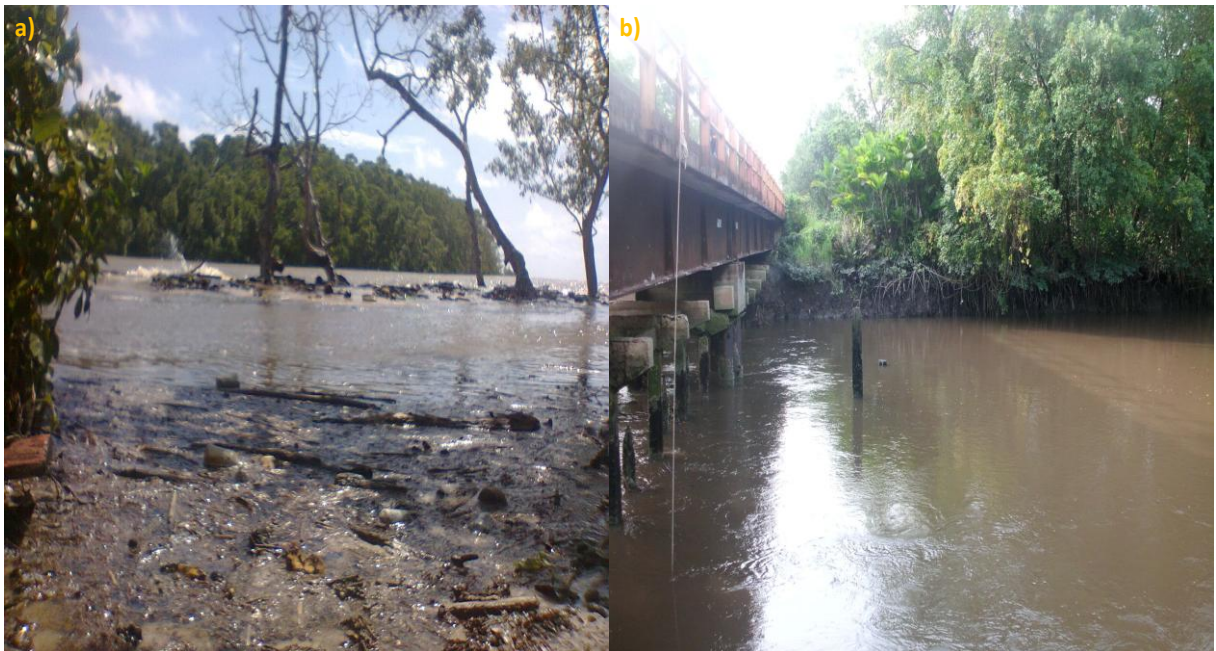
Figura 10- Canal de maré do Jubim (Salvaterra/ Pa). A) Desembocadura e b) interior-Ponte.
