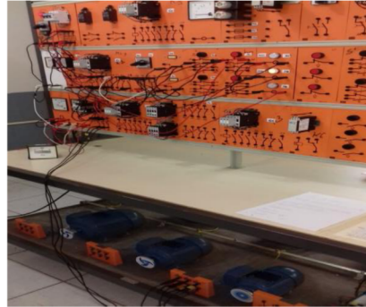
Partida de motor-bomba trifásica
