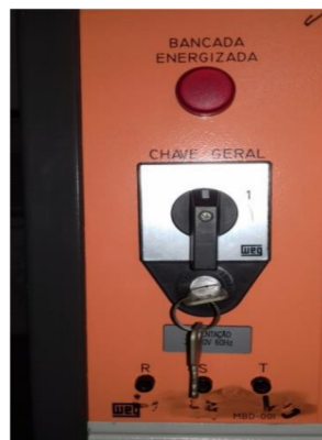
Figura 19. Chave Seccionadora (Tipo Pacco).
