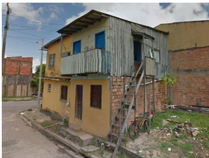
Figura 23 – Casa construída parcialmente de madeira.
