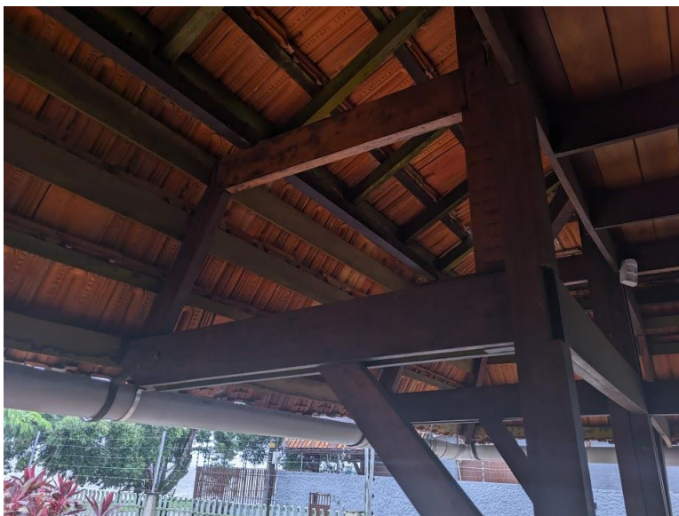
Figura 12 — Estrutura do Beiral Quebra-sol/Quebra-chuva
