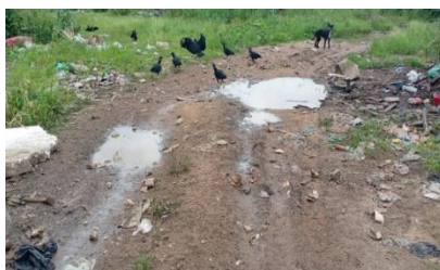
Figura 17 – Evidências de solo escurecido com presença de manchas de chorume e degradação da camada superficial.
