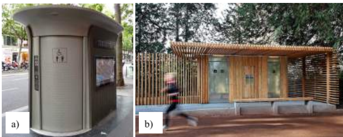
Imagem 38: Banheiros públicos. a) Banheiro público com portas automáticas nas ruas da França; b) Banheiro localizado em praça pública na China.
