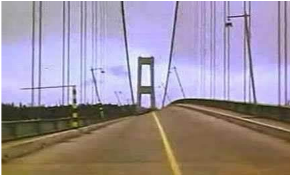
Figura 2 - A queda da ponte Tacoma Narrows
