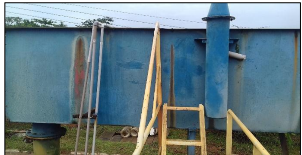
Figura 12 - Mistura rápida (C. Parshall)
