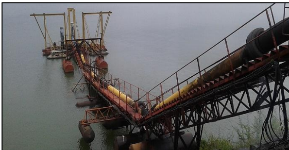
Figura 11 - Unidade de captação de água
