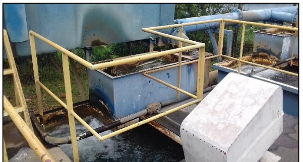
Figura 14 - Unidade de mistura lenta (Floculador)
