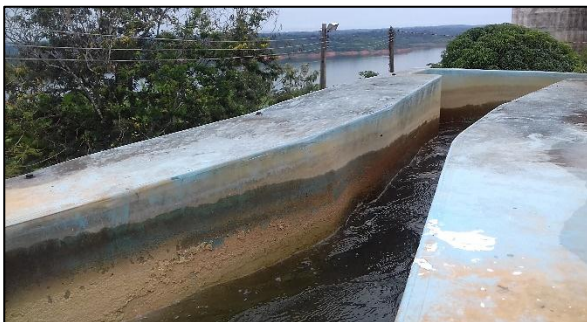
Figura 13 - Calha parshall
