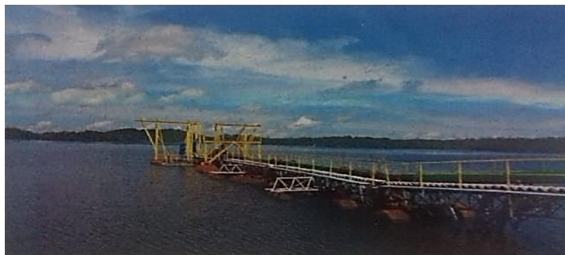
Figura 10 - Captação e adução de água bruta (Lago da UHE Tucuruí).
