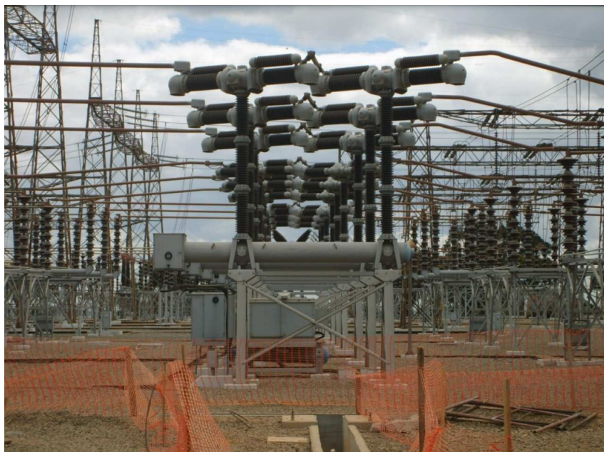
Figura 4 – Disjuntores a ar comprimido com quatro câmaras de sopro axial em dupla direção.
