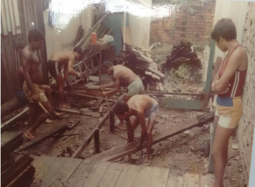
Fotografia 1 – Construção do espaço
