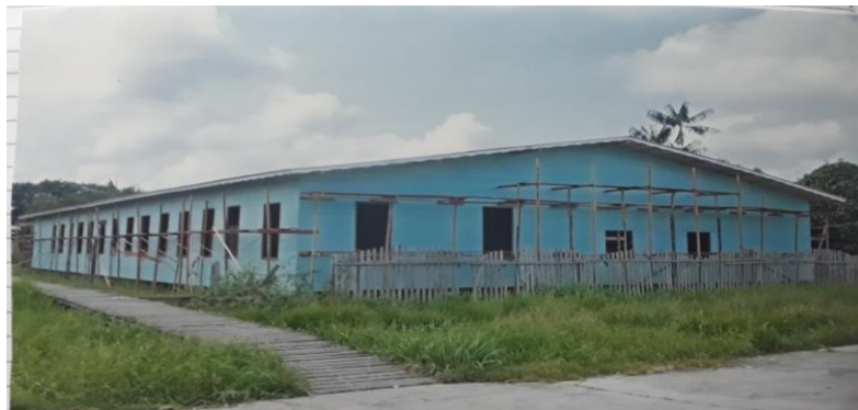
Figura 11 – O Centro sendo reformado e ampliado no ano de 2012
