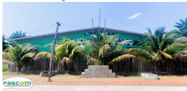
Figura 14 – Fachada do Centro
