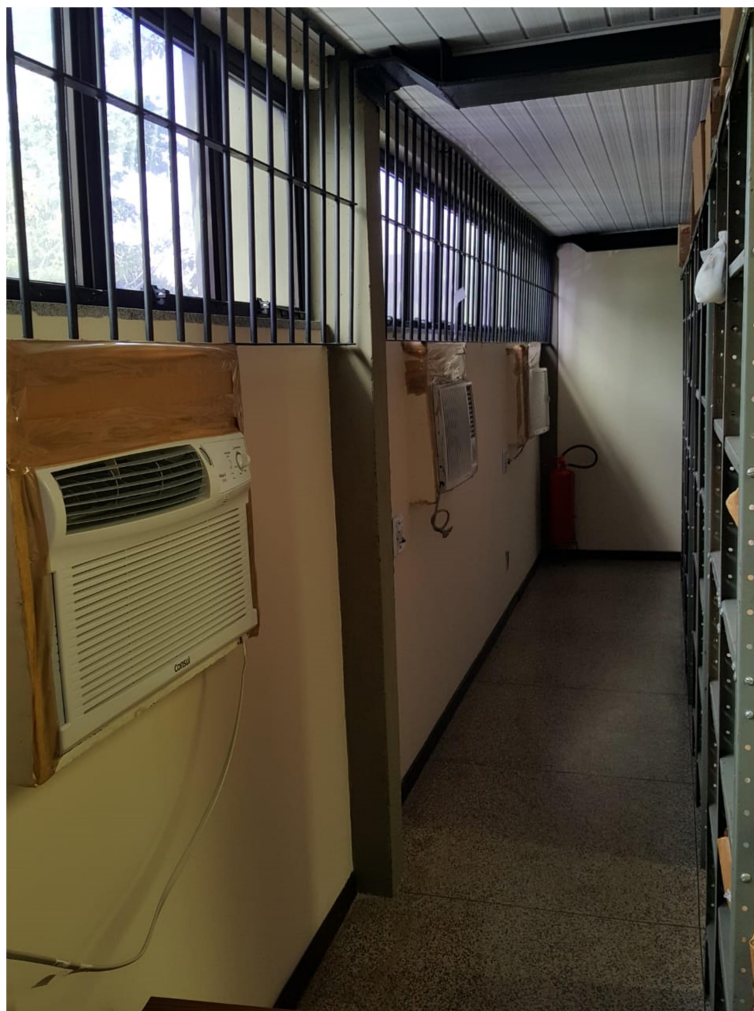
Figura 2: imagem da janela e ar condicionado
