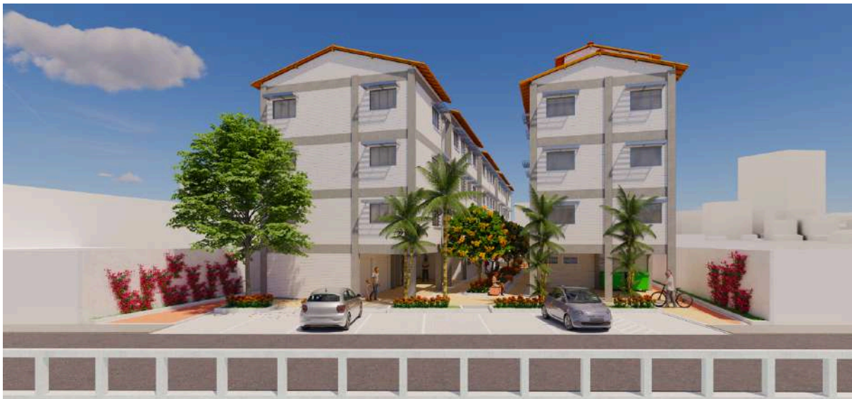
Figuras 32 e 33 - Fachada da Rua do Canal Água Cristal (acima) e fachada lateral blocos 1 e 2 (abaixo).
