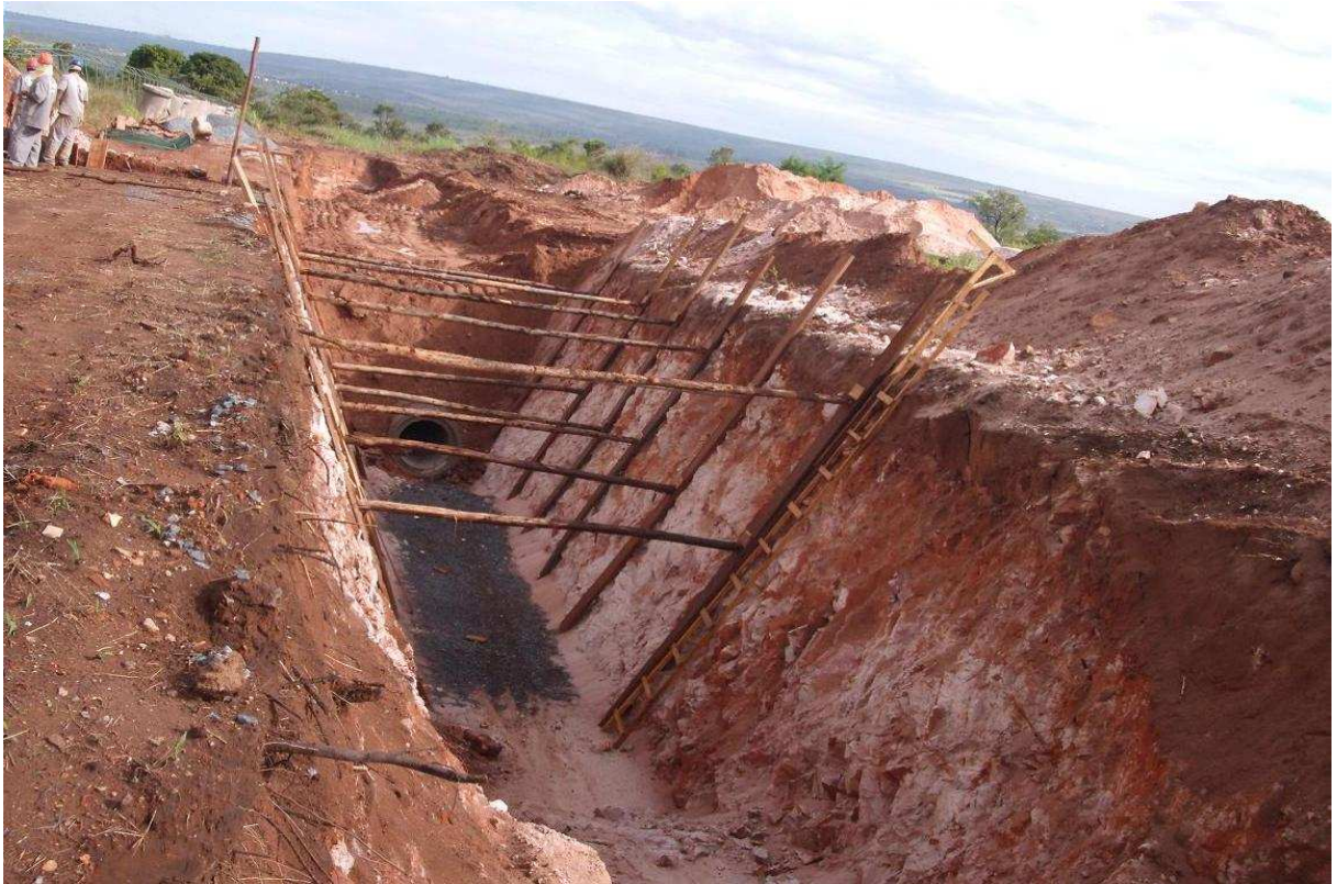
Figura 8.8 – Escavação em trincheira para rede tubular de águas pluviais de \varnothing 500 mm, próximo à via W-7. Escavação mais rasa (cerca de 4 m de profundidade) sobre o leito de quartzito. (UTM SICAD 23 L 188.339 E / 8.256.061 N).
