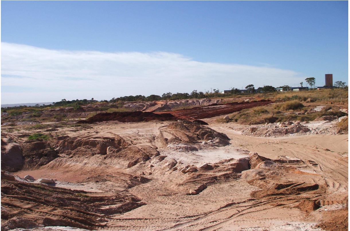
Figura 7.11 – Cava principal da Jazida do Canil em 2007 (sentido de visada NW – SE) no início dos trabalhos de terraplanagem e recomposição topográfica. (UTM SICAD 23 L 187.398 E / 8.255.855N)
