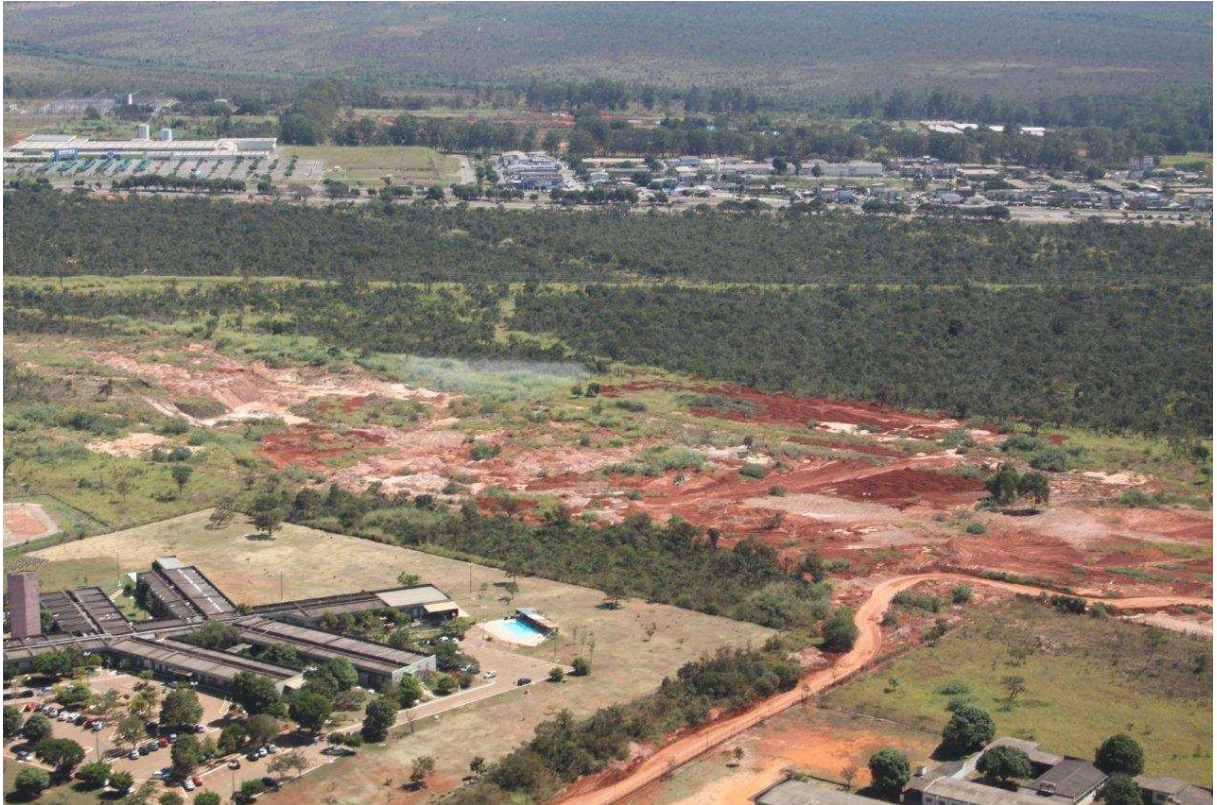
Figura 6.13 – Sobrevôo da Jazida do Canil em 21/05/2010 mostrando parte da área já terraplanada e revegetada por espécies arbustivo-herbáceas exóticas.
