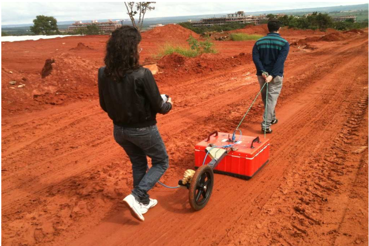
Figura 9.9 – Aquisição de dados próximo ao final do Perfil GPR A-B, no acesso paralelo à via W-7 (em obras neste ponto), do outro lado do alto topográfico do pacote de quartzito. (UTM SICAD 23L 188.336 E / 8.256.498 N).
