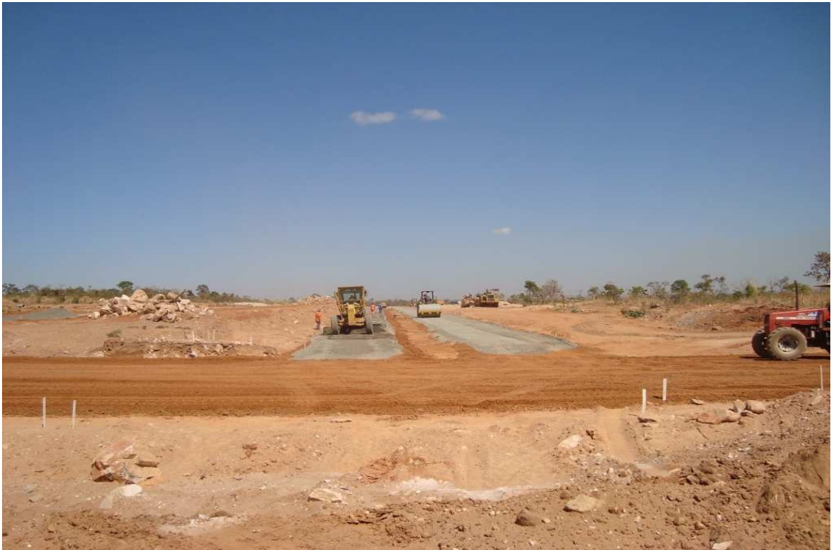
Figura 8.5 – Trabalhos de pavimentação das vias coletoras da futura quadra SQNW 107 (2010) e ligação com a futura via W-7 do SHCNW. Notar a presença de neossolos e blocos de quartzito. (UTM SICAD 23 L 188.361 E / 8.256.148 N).
