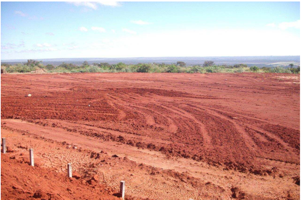
Figura 7.14 – Cava principal da Jazida do Canil em 2011 (sentido de visada SE - NW) após a conclusão dos trabalhos de terraplanagem para recomposição topográfica da cava. (UTM SICAD 23L 187.349 E / 8.255.738 N)
