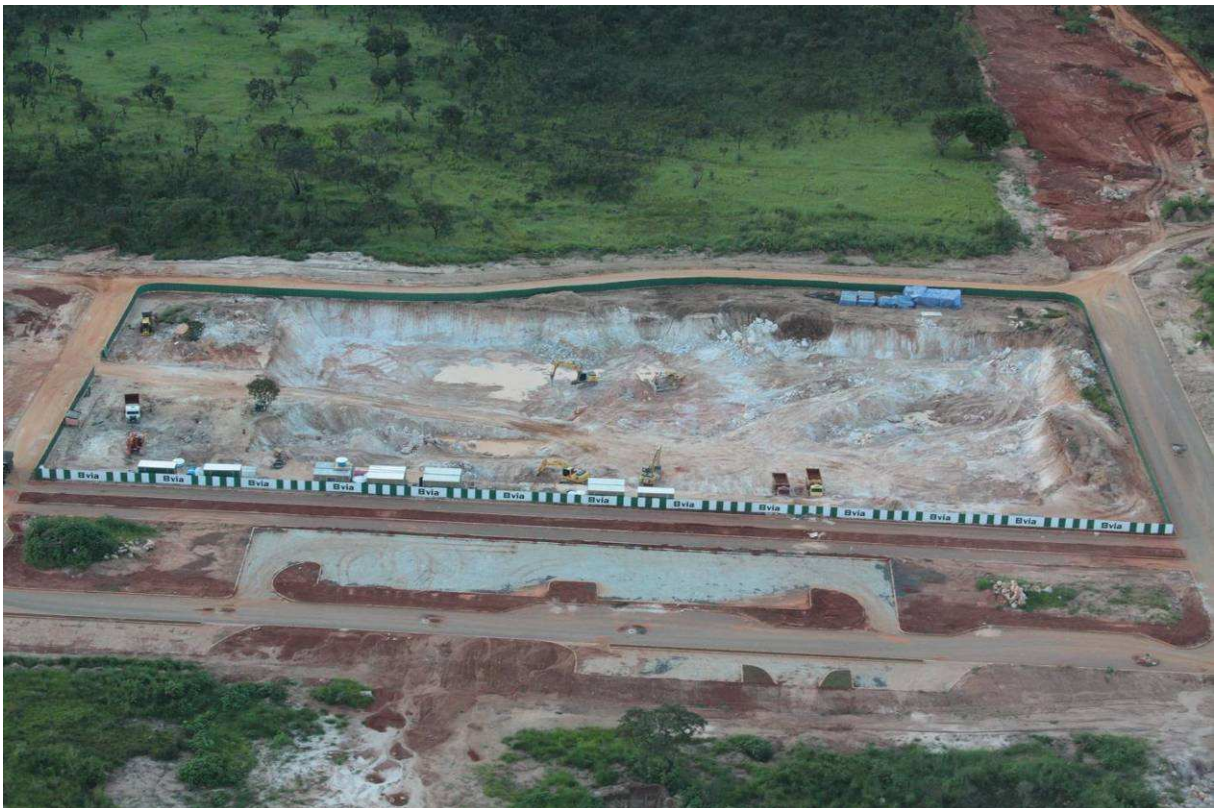
Figura 8.6 – Escavação predial sobre a parte central do pacote de quartzito para edificação dos blocos B e C da futura quadra SQNW 107, em 2011 (detalhe na figura 5.4). Notar os trabalhos pavimentação e calçamento vistos na figura 8.4 parcialmente concluídos.
