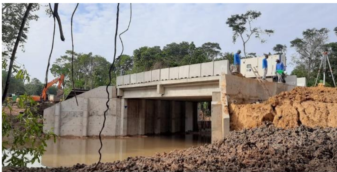
Figura 5: imagem da ponte de concreto construída sobre o furo da Vila de Beja
