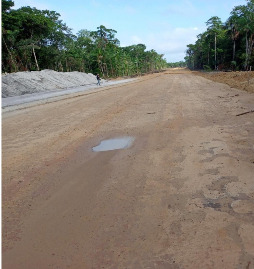
Figura 3: Abertura do ramal de acesso ao TUP ao porto da praia da Jurutuba
