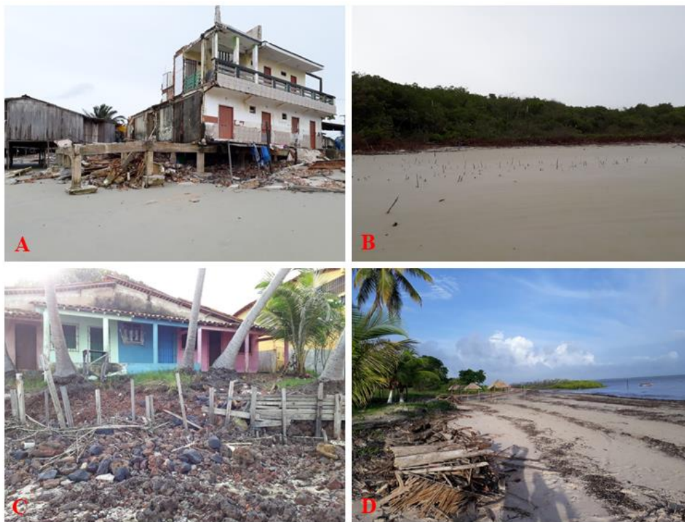
Figura 29- Exemplos de construções destruídas e estáveis para a determinação do grau de danos. A)Praia de Crispim setor central, B)Praia de Crispim setor norte, C)Praia de Marudá e D)Praia de Santa Maria. Fotografia retirada em 15/03/2018.
