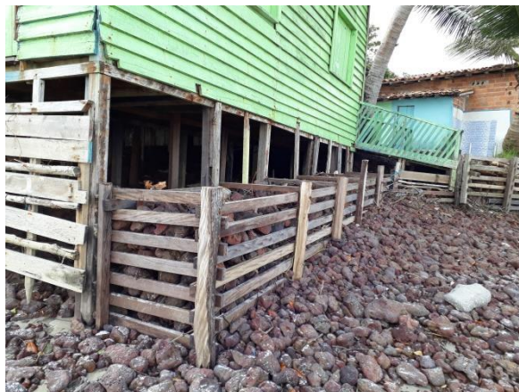
Figura 30- Obras de proteção realizada por um morador na Praia de Marudá. Fotografia retirada em 15/03/2018.
