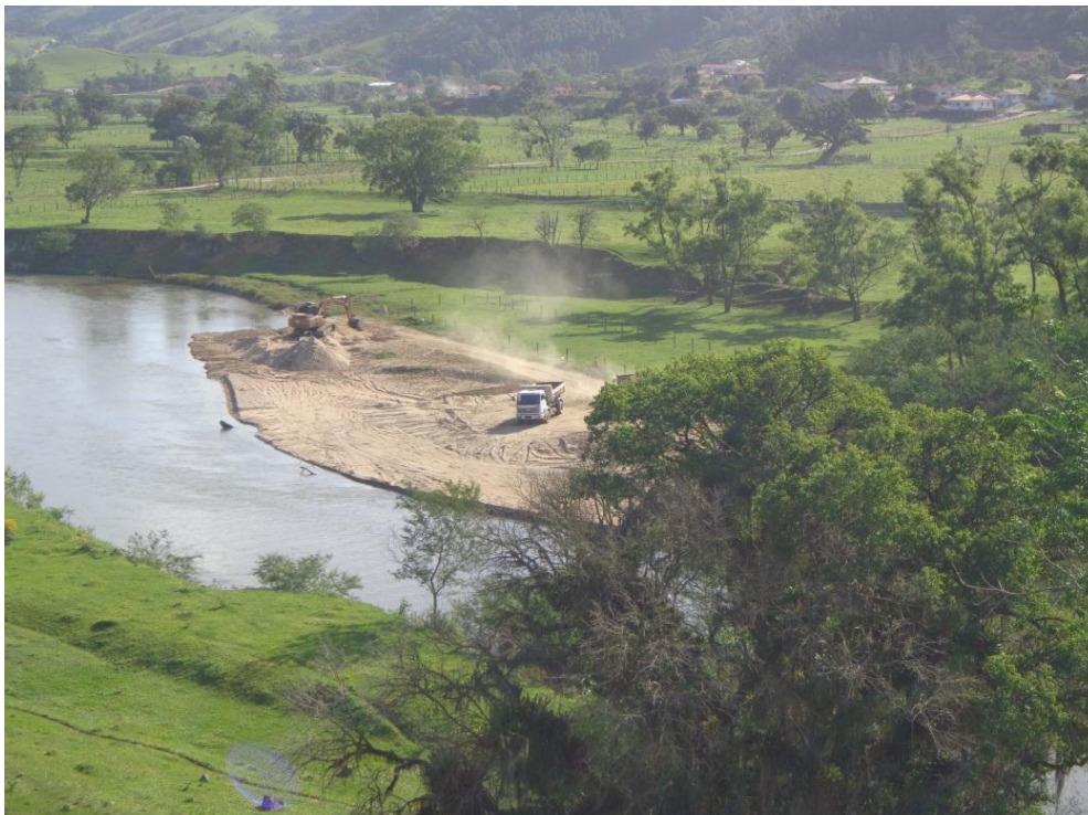
Figura 7 - Retroexcavadeira e caminhões responsáveis pelo transporte de areia em operação. (Fonte: MARCELINO, 2013).
