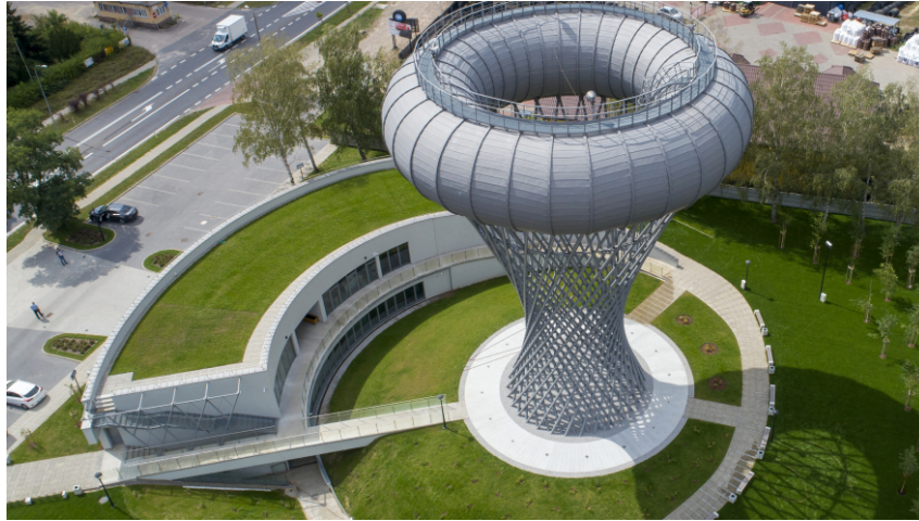
Figura 7: Caixa d'água no formato toroidal (Polônia).
