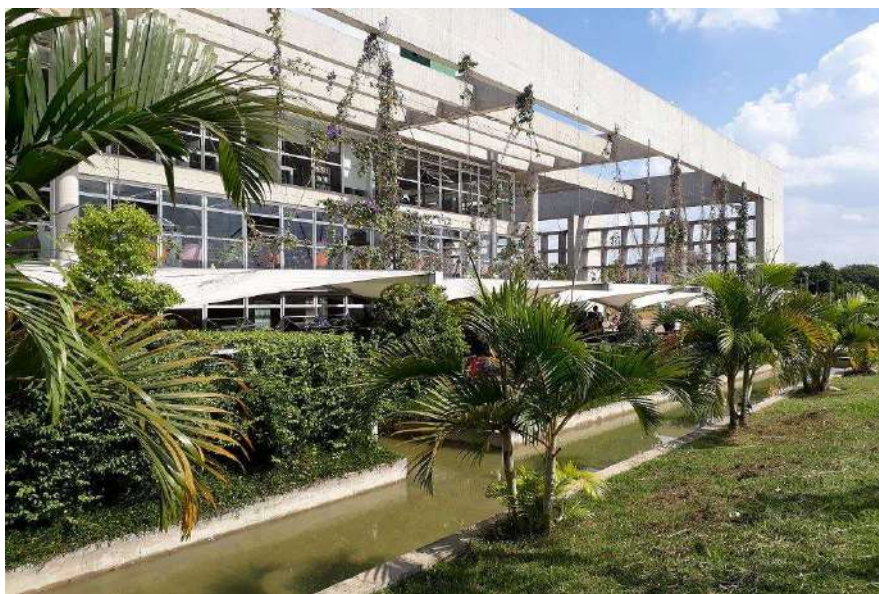
Figura 20 – Cabos de aço cobertos por vegetação
