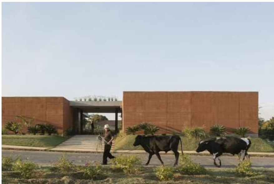
Figura 13 – Fachada principal fazendo uso da terra como matéria-prima essencial
