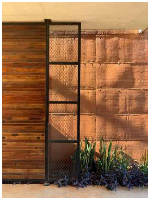
Figura 12 – Paredes externas feitas de terra
