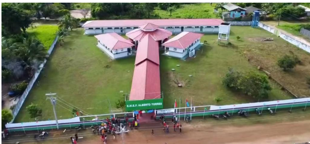
Imagem 2 – Estrutura total da escola.
