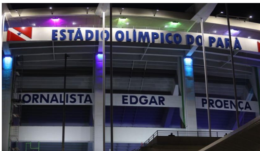
Fig. 46 - Estádio Olímpico do Mangueirão. Fonte: Agência Pará. 2023
