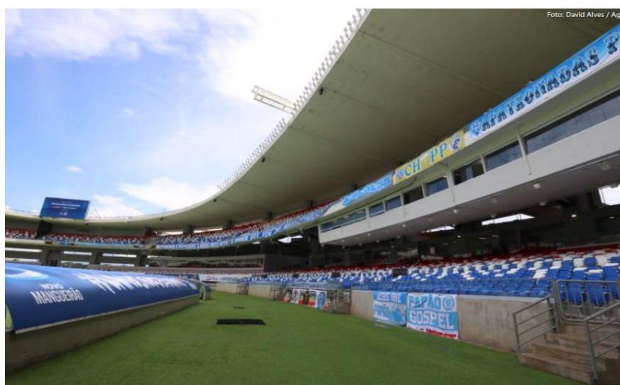
Fig. 49 - Banzo da Cobertura completamente restaurado e acabamento em tons brancos, junto das cabines. Fonte: Agência Pará. 2023
