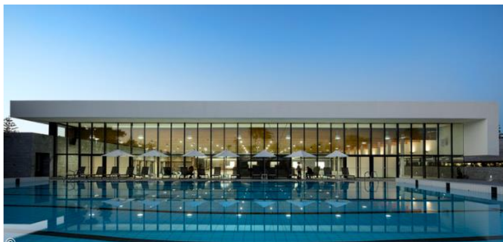
Fig. 18 - Relação entre a piscina aberta e o pavilhão que comporta a piscina coberta, horizontalidade através da volumetria e platibandas estão presentes ao longo de todo o projeto. Fonte: Archdaily. 2018
