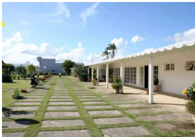
Fig. 35 - Restaurante do Centro - Fonte: Slideshare. 2012
