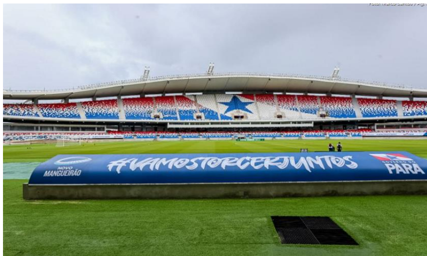
Fig. 48 - Novas arquibancadas do estádio, compondo a bandeira do Pará, acessos para os assentos alargados para seguir padrão de acessibilidade FIFA. Fonte: Agência Pará. 2023
