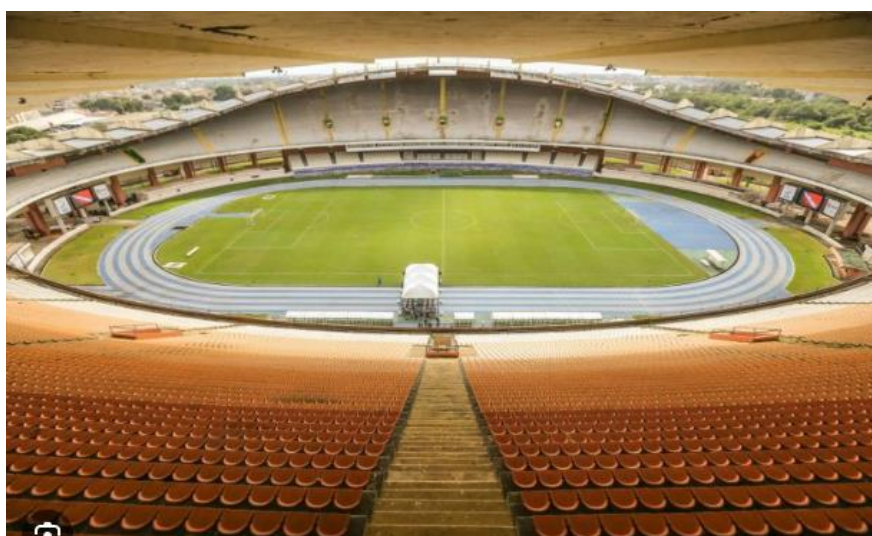
Fig. 47 - Arquibancadas em acabamentos em tons alaranjados, antes da reforma de 2021. Fonte: Câmara dos Deputados. 2021
