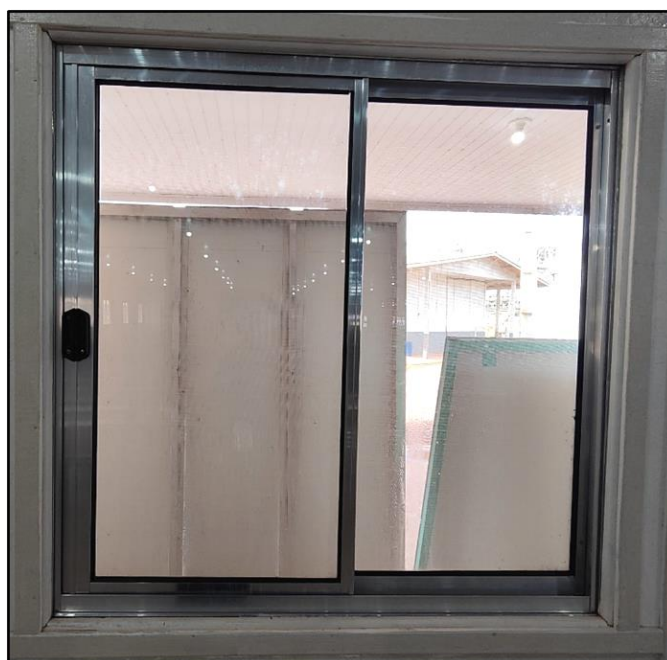
Figura 16: Janelas do tipo blindex do refeitório
