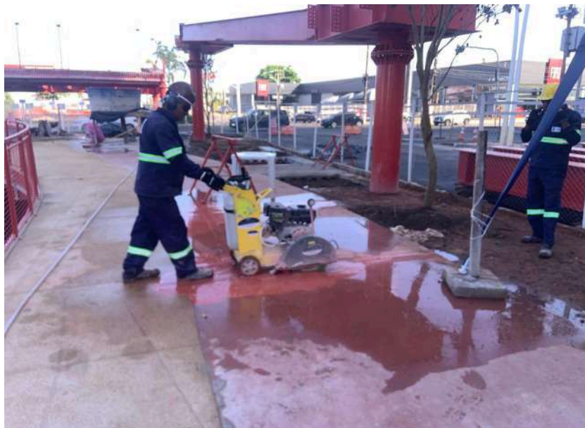
Figura 6: Execução de corte das juntas serradas (Autores, 2025)
