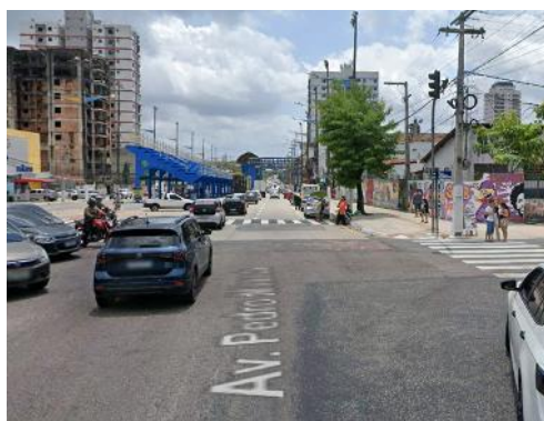
Figura 7- Trechos com Pavimento Rígido e Flexível.
