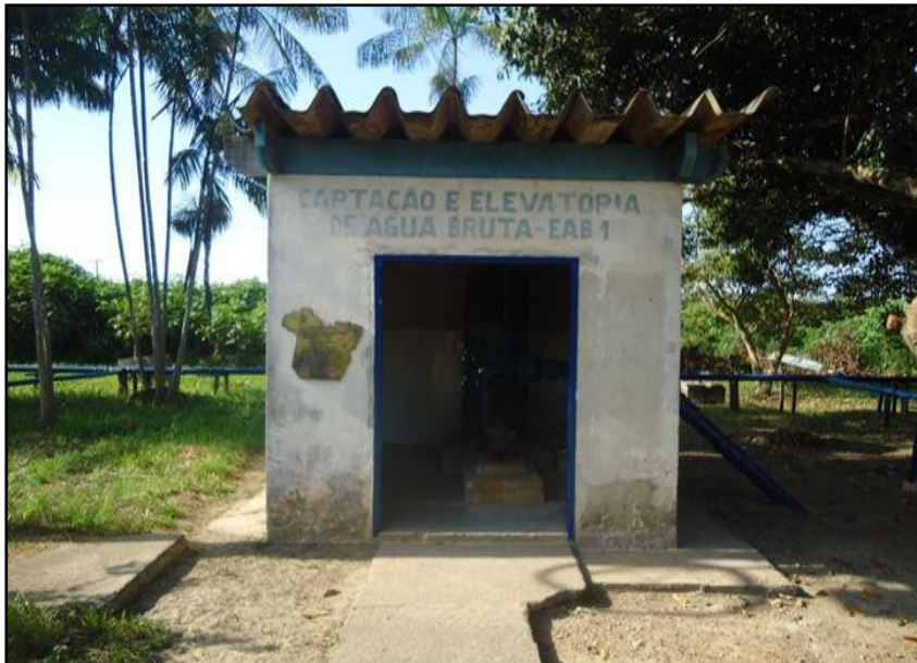
Figura 5 - Fotografia da casa de captação e elevatória de água bruta- EAB1
