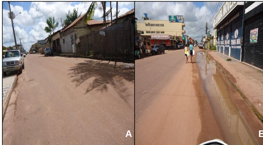
Figura 12 - Rua com rede de distribuição de água: A e B - Avenida Natal
