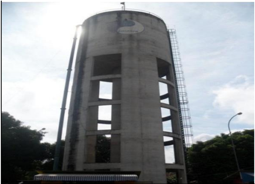
Figura 8 - Reservatório elevado de água tratada desativado e em construção
