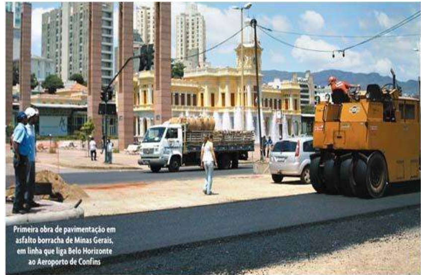
Figura 6: Primeira obra de asfalto-borracha em Minas Gerais/Brasil
