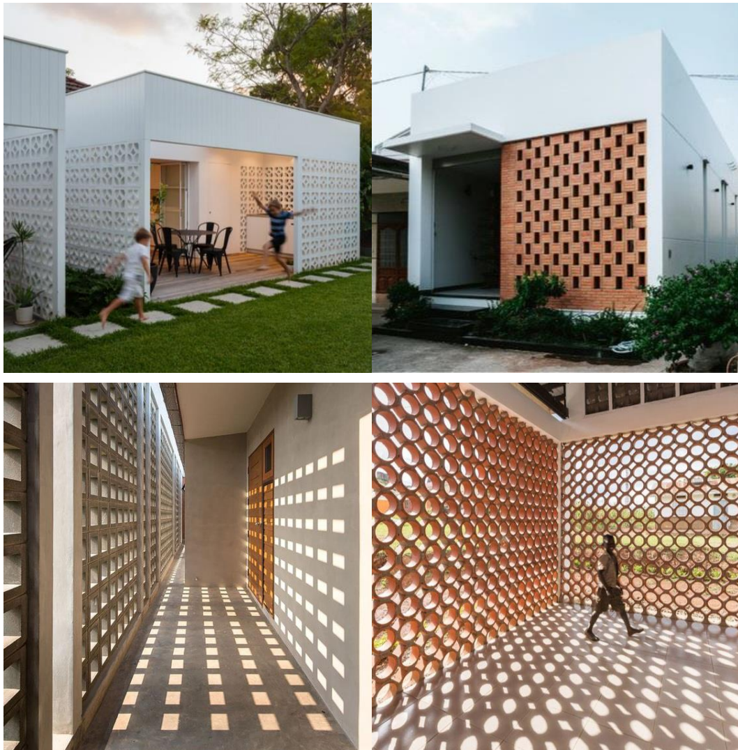
Figura 48: Uso de elementos vazados em paredes externas
