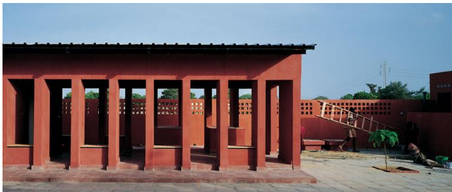
Figura 17: Ritmo na fachada e cobogós de concreto – Centro das Mulheres
