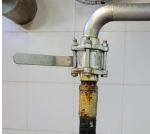
Figura 3 – Válvula esférica de inox 304 e conexão hidráulica de aço 1112.
