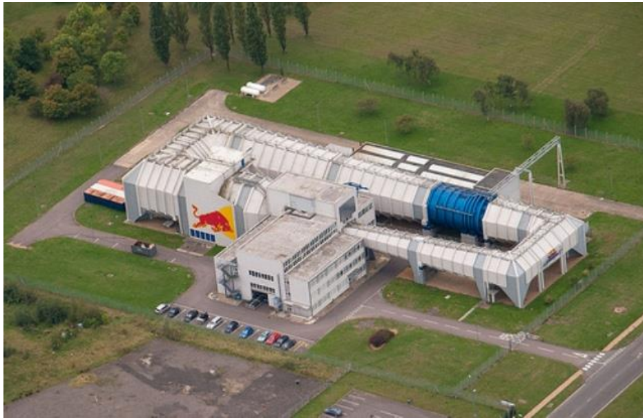
Figura 7 - Túnel de vento de circuito Red Bull.
