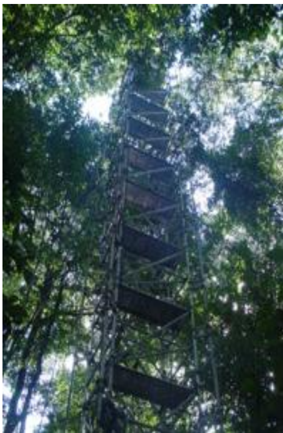
Figura 02 – Torre micrometeorológica de 42 metros do projeto ESECAFLOR.
