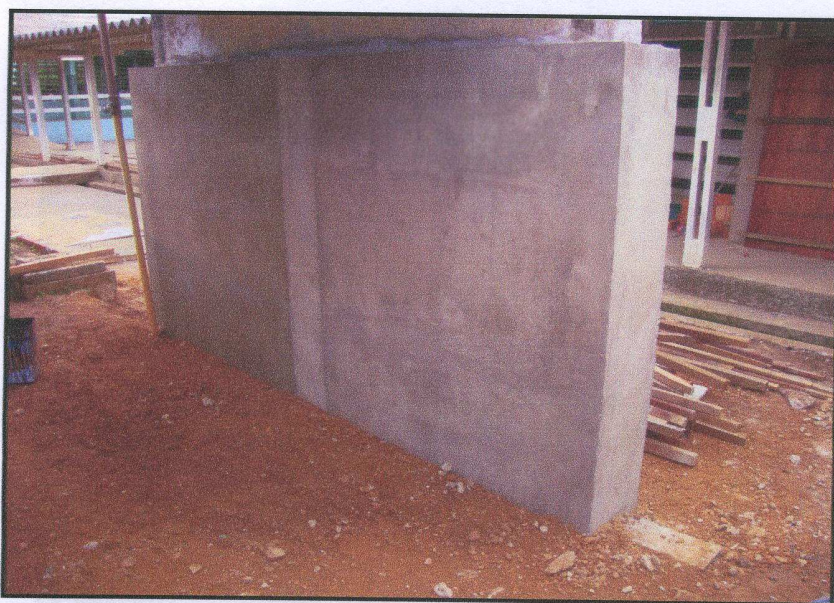
Figura 4. 108 – Conclusão da reforma na base da caixa d'água.
