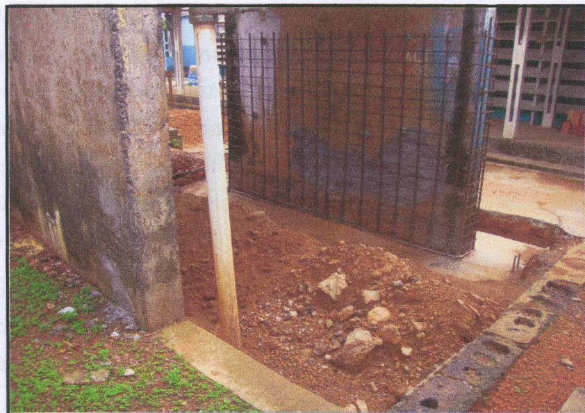
Figura 4. 107 – Início da reforma na base da caixa d'água.
