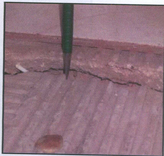
Figura 4.20.1 – Abertura do piso recalcado.
