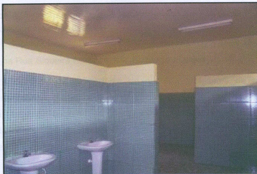
Figura 4. 64 – Reforma do banheiro.
